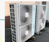
▲室外機の特種塗装
