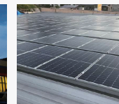
▲自家消費型太陽光パネル設置
