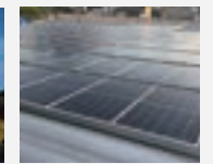
▲自家消費型太陽光パネル設置
